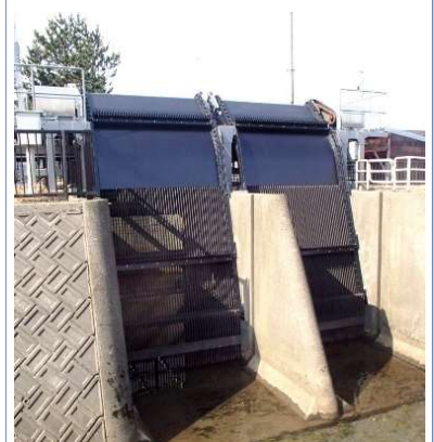
石川県・安産(やすまる)川排水機場機械設備修繕工事
