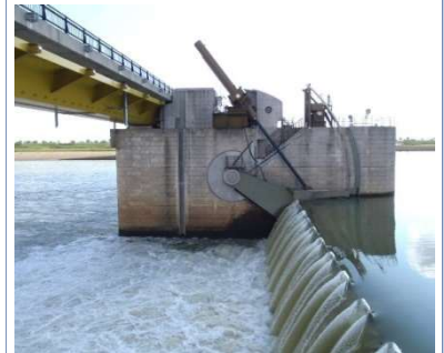
新潟県・大河津可動堰ゲート改良工事
