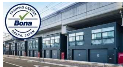
【Bona トレーニングセンター大阪（2024 年に開設）】
